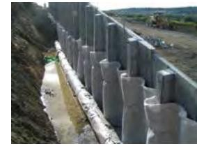
Das Geokomposit PAVIDRAIN eignet sich besonders für begrünte Dächer und unterirdische Bauwerke. Es kann auch in verstärkten Lehmkonstruktionen, Wasserbauwerken, Stollen und Deponien eingesetzt werden.
