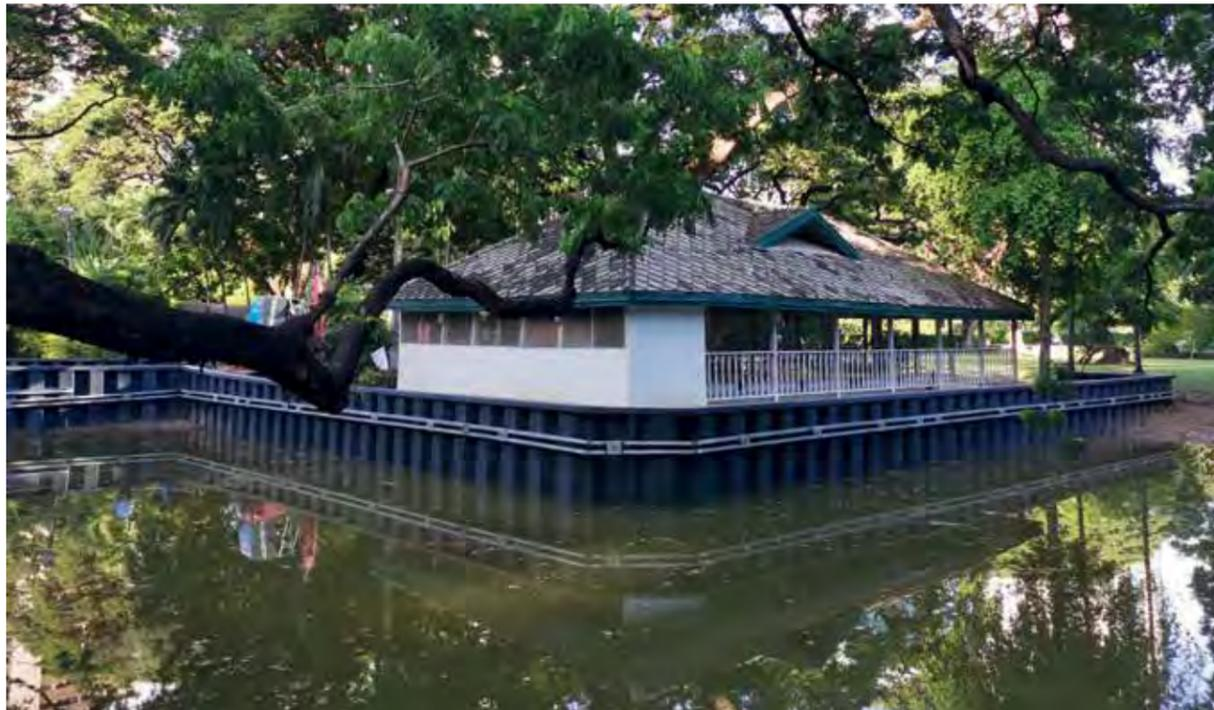
PALPLANCHES EN VINYLE UTILISÉES POUR LA CONSTRUCTION DE L'INFRASTRUCTURE VERTE ET BLEUE SUR LE TERRAIN DE L'AMBASSADE DES ÉTATS-UNIS À BANGKOK.
