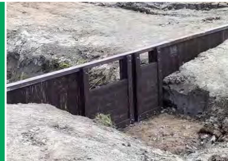
SUÈDE: LA PREMIÈRE BARRAGE DE RÉTENTION DES EAUX PLUVIALES INSTALLÉES À L'ÉTRANGER.
