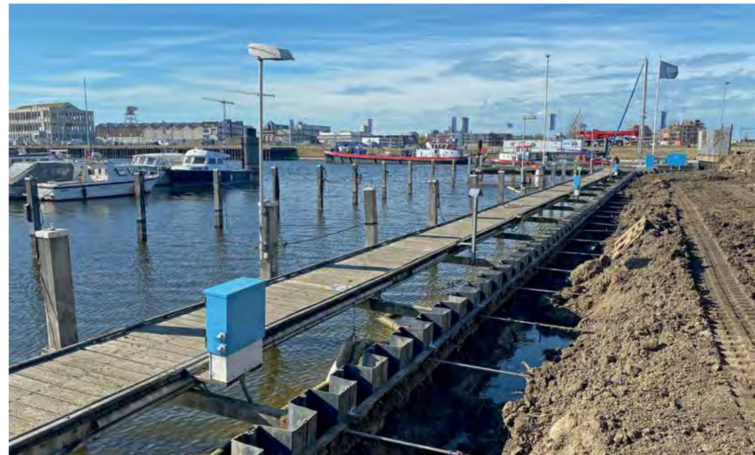
VLISSINGEN, PAYS-BAS: CONSTRUCTION EN PALPLANCHES EN VINYLE RENFORCÉE PAR LE SYSTÈME D'ANCRAGE DANS LA CONCEPTION DE LA MODERNISATION DU PORT.
