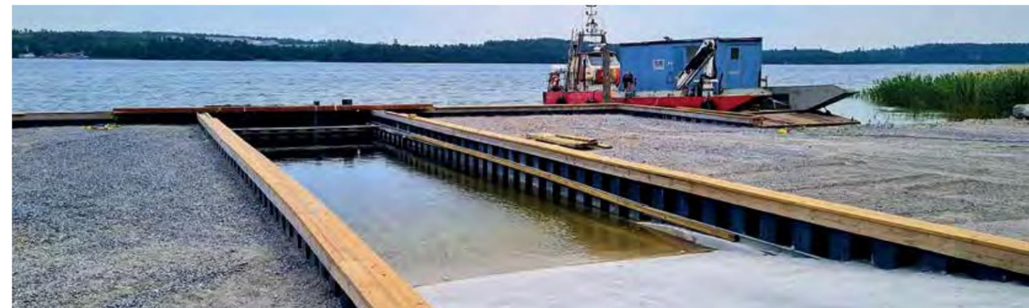
PALPLANCHES HYBRIDES SUPERLOCK UTILISÉES POUR LA CONSTRUCTION D'UNE RAMPE DE MISE À L'EAU DES BATEAUX.
