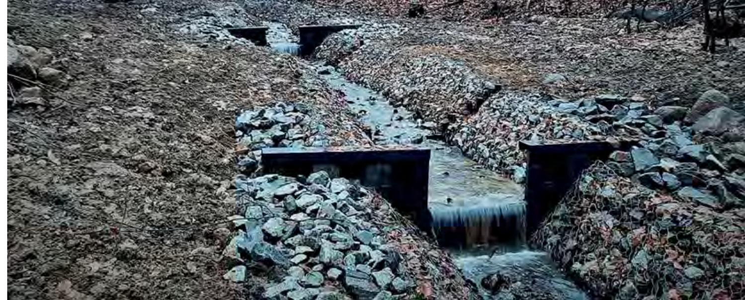
SYSTÈME DES SEUILS D'EAU INSTALLÉS POUR RALENTIR LE COURS D'EAU DU RUISSEAU.
