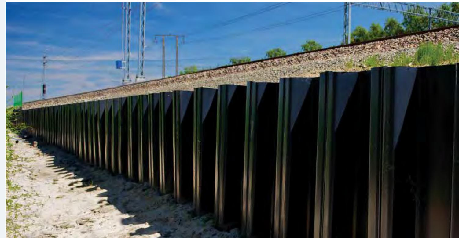
STABILISATION DE LA PENTE DE REMBLAI DE LA VOIE FERRÉE.
