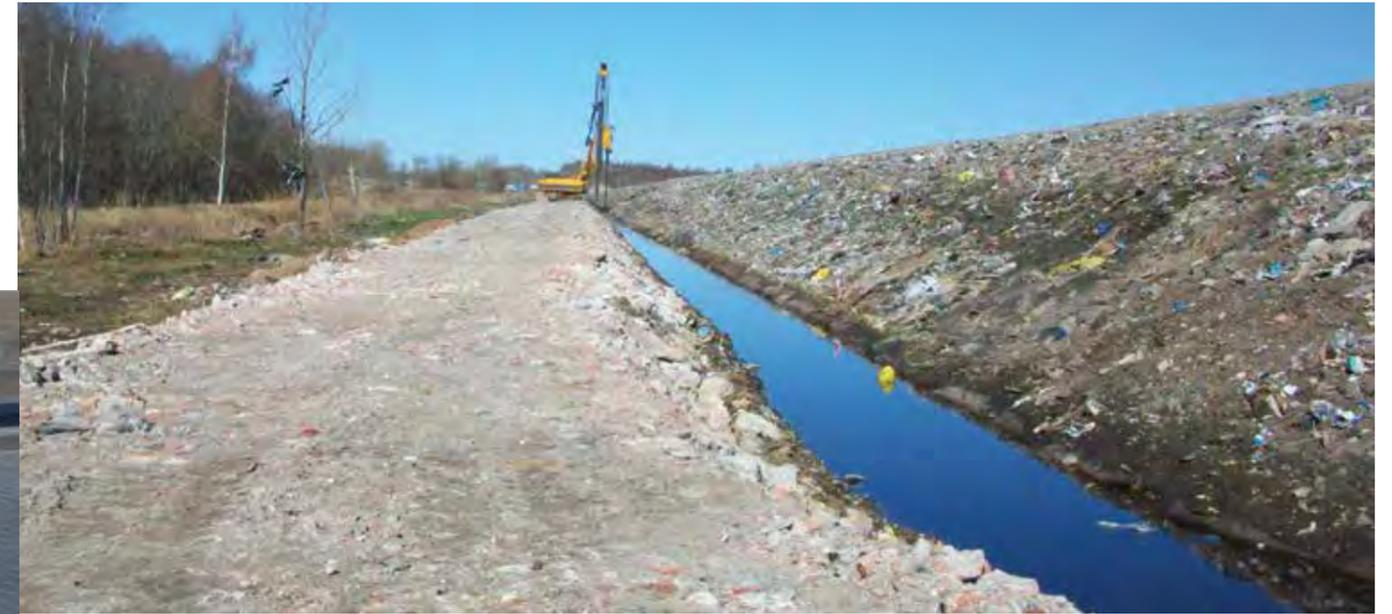
RÉALISATION D'UNE PROTECTION DE FILTRATION À LA DÉCHARGE DE DÉCHETS CHIMIQUES DE L'INDUSTRIE DU TANNAGE.
