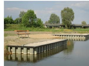
Compte tenu de leur totale résistance aux facteurs biologiques et atmosphériques, ainsi que dommages mécaniques, les palplanches en PVC peuvent être utilisées dans un large éventail de projets de génie civil. Les palplanches EcoLock utilisées à la place des murs de soutènement en acier réduisent les coûts d'installation et matériaux. En alternative aux solutions en bois, EcoLock garantit une durabilité et une résistance .
