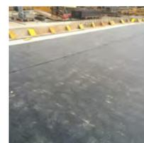
Il faut installer le **Stratoplast SUPER** avec le film en polyoléfine blanc en été et le côté noir en hivers. Ce produit est indiqué pour travaux en tunnel, terrassement, canaux artificiels et fondations.
