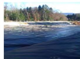
Il faut installer le **Stratoplast** avec le couche en géotextile sur le membrane le film en polyoléfine reste en contact avec le ciment. Ce produit est indiqué pour travaux en tunnel, terrassement, canaux artificiels et fondations.
