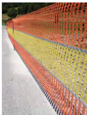
FILET DE CHANTIER
