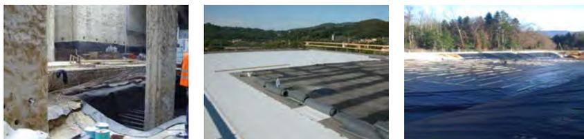
Il faut installer le **Stratoplast** avec le couche en géotextile sur le membrane le film en polyoléfine reste en contact avec le ciment. Ce produit est indiqué pour travaux en tunnel, terrassement, canaux artificiels et fondations.
