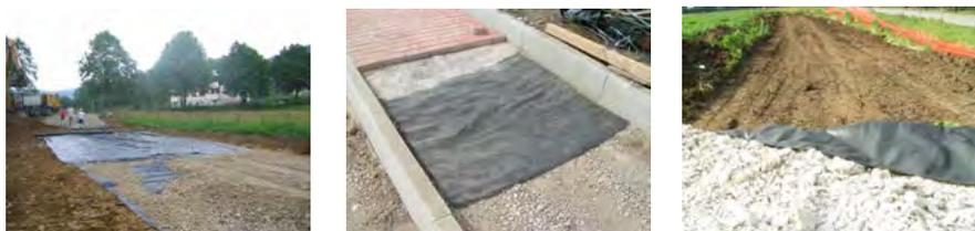
Le géotissé PAVIROCK B trouve des applications dans les constructions routières et ferroviaires ainsi que dans les renforcements de talus en terre.
